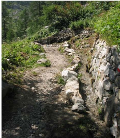
Ripristino regimazione acque
