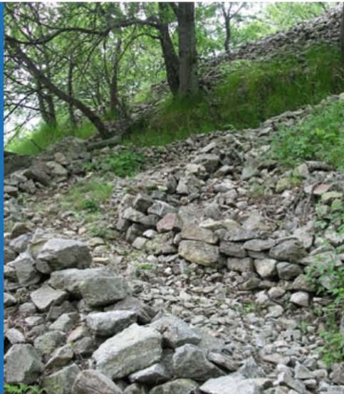
Muretti in pietra ripristinati
