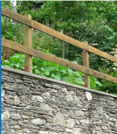
Recinzione su muro di controterra in pietra
