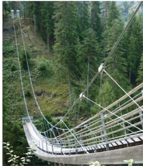
Neuer Traversina-Steg, Svizzera
