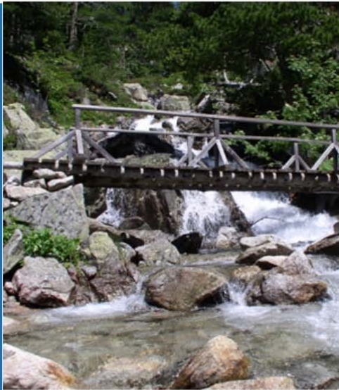
Ponte in legno su torrente
