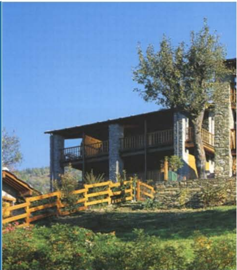
Recinzioni di nuova realizzazione, Ostana, Valle Po
