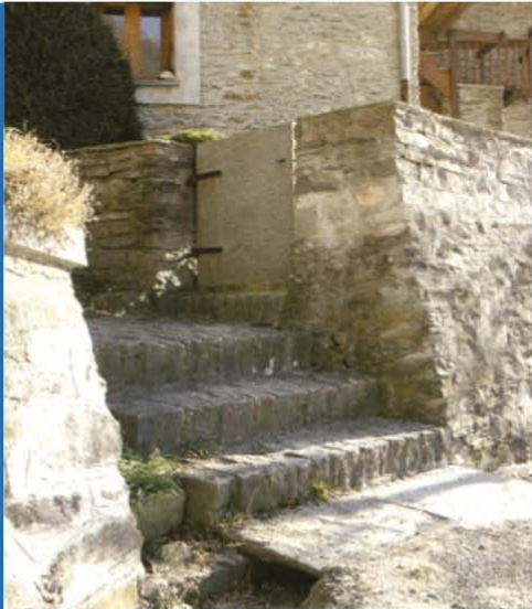
Esempio di muro controterra in pietra di nuova
