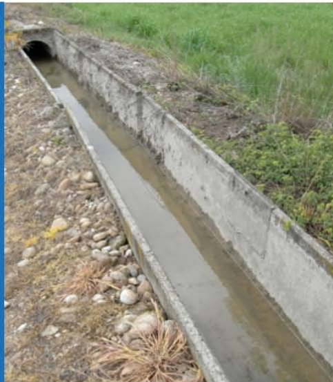
Canale irriguo in cls
