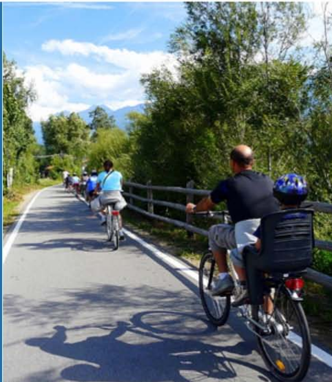
Pista ciclabile con fondo asfaltato
